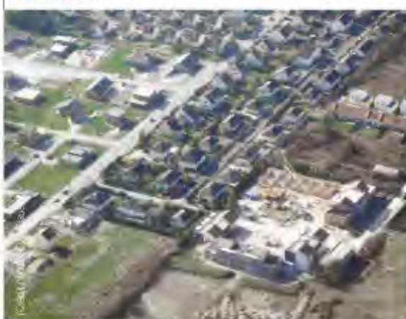
À gauche l'éco-lotissement Lebocey, à droite l'éco-quartier qui prend forme également sur l'emprise de l'ancien camp du Moulinet, à Pont-Sainte-Marie. Entre les deux, une zone pavillonnaire plus ancienne.
